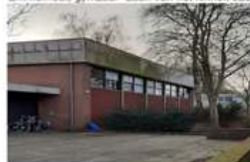
Emmerhout, gymzaal "Laan van het kinkholt 325
